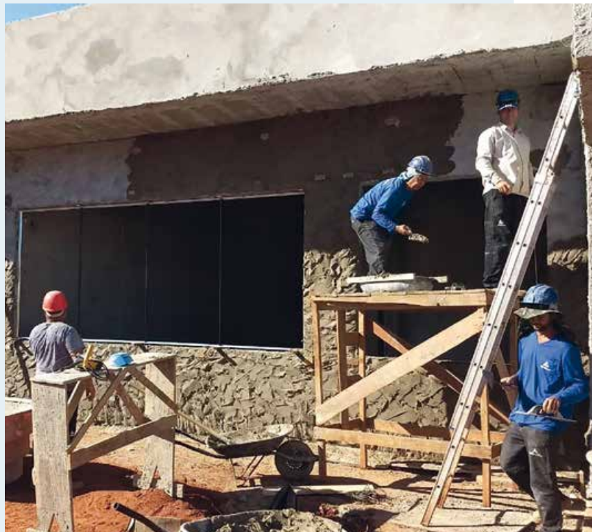
Obras em Umuarama
