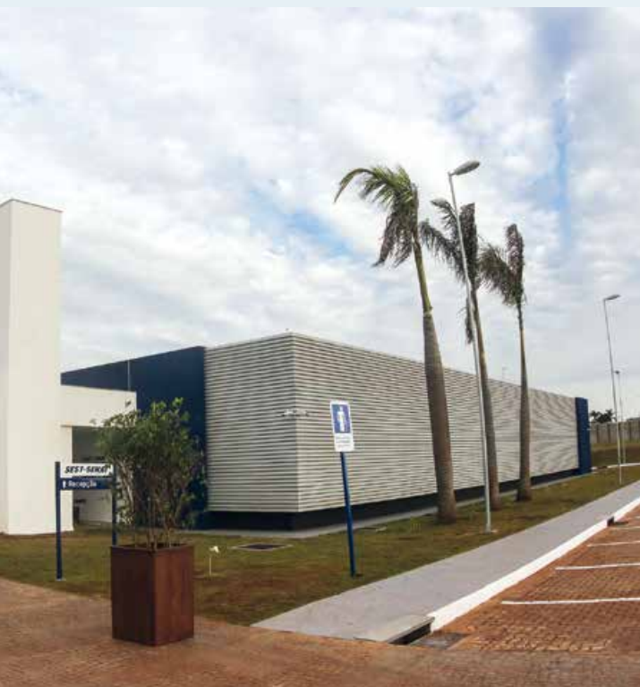
Fachada do Sest Senat Maringá
