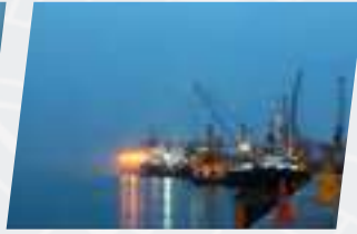
Infraestrutura de acostagem disponibilidade de berços e piéres para atracação
